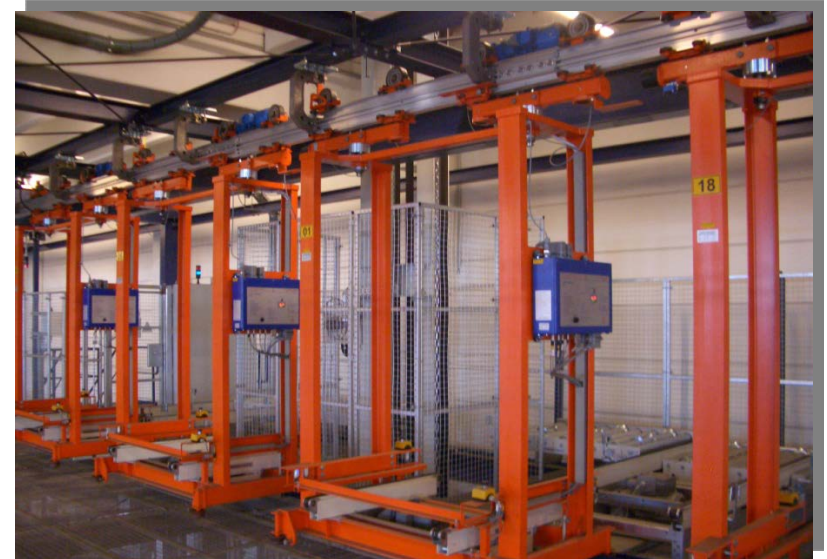
Electrovía para almacén de Paletas
